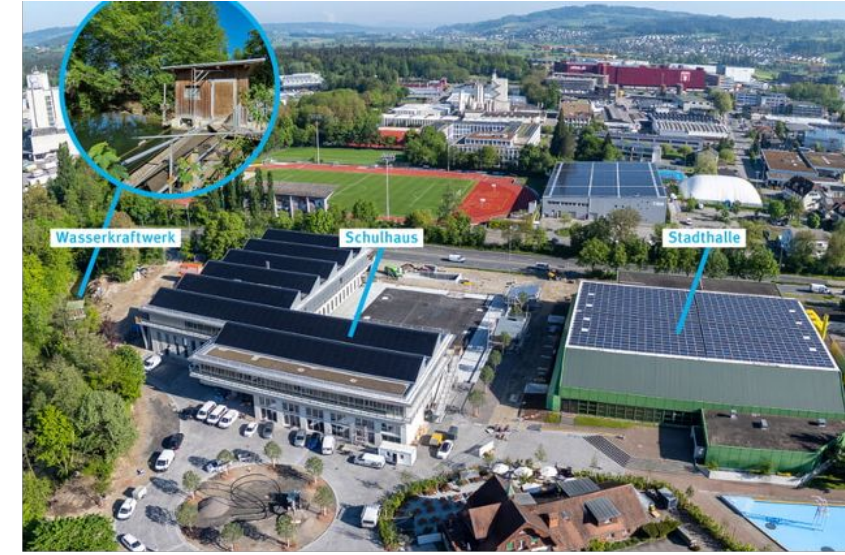
Waterkraftwerk Schulhaus Sursee
